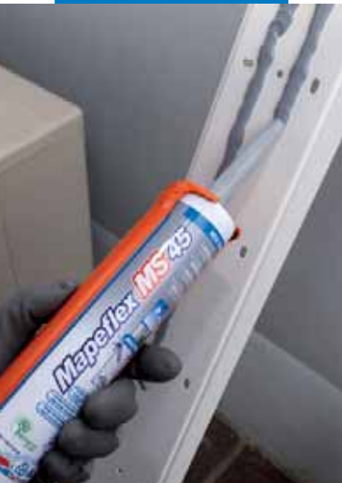
Lepení plastových profilů v exteriéru
